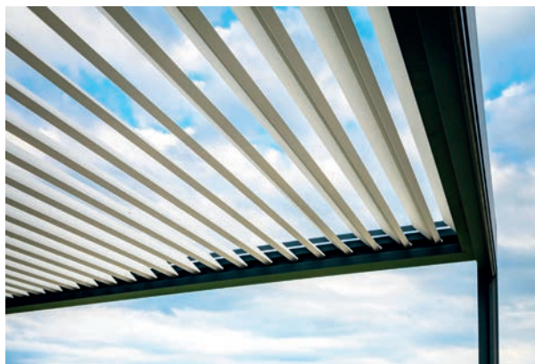
DAKPANELEN DRAAIEN VAN 0° - 135°.
